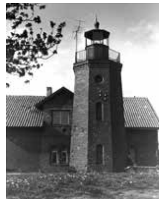
Ventės rago ornitologijos stotis. 1929 m.
